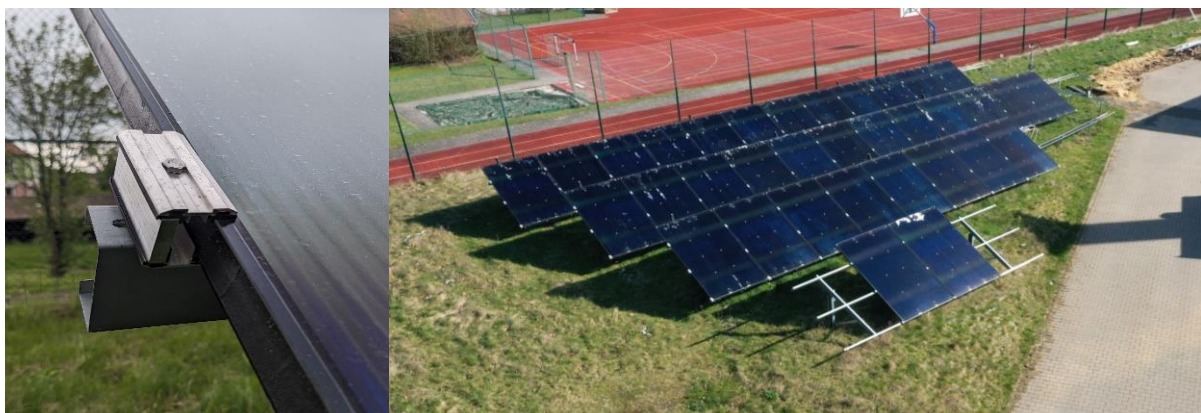
Abbildung 59: Verwendete PV-Laminatklemmen und Gesamtansicht des Kollektorfelds
