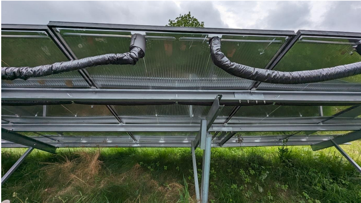
Abbildung 62: Kollektorreihe von hinten. Sammelleitung verläuft an der Querschiene des Gestells und die Kollektoren sind über Wellrohr aneinander angeschlossen.
