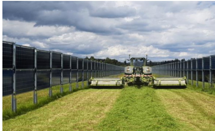
Abbildung 74: Bifaziales Agri-PV-System, installiert von Next2Sun [68]
