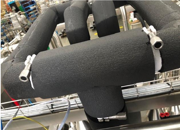
Abbildung 74: Isolation der Kaltluftzuführung für den Einfrierturm
