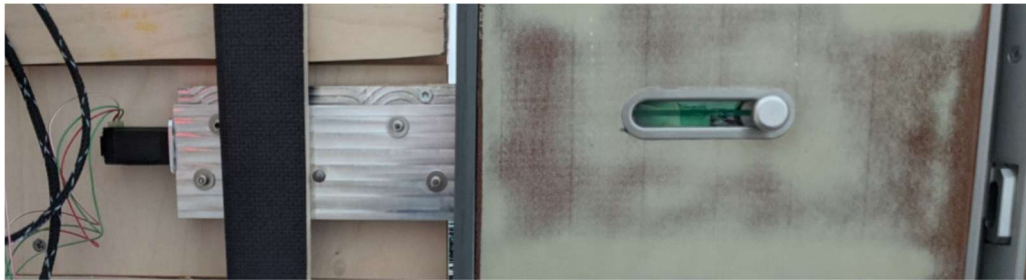
Abbildung 6-24 Verriegelungsaktuator (links) mit üblicher manueller Verschlussbedienung (rechts)
