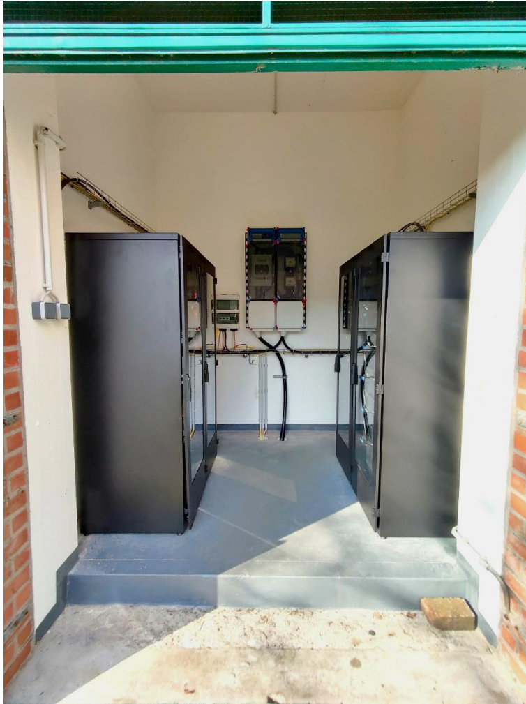
Abbildung 14: Ehemaliger Transformatorraum (nach der Installation des Batteriespeichers)
