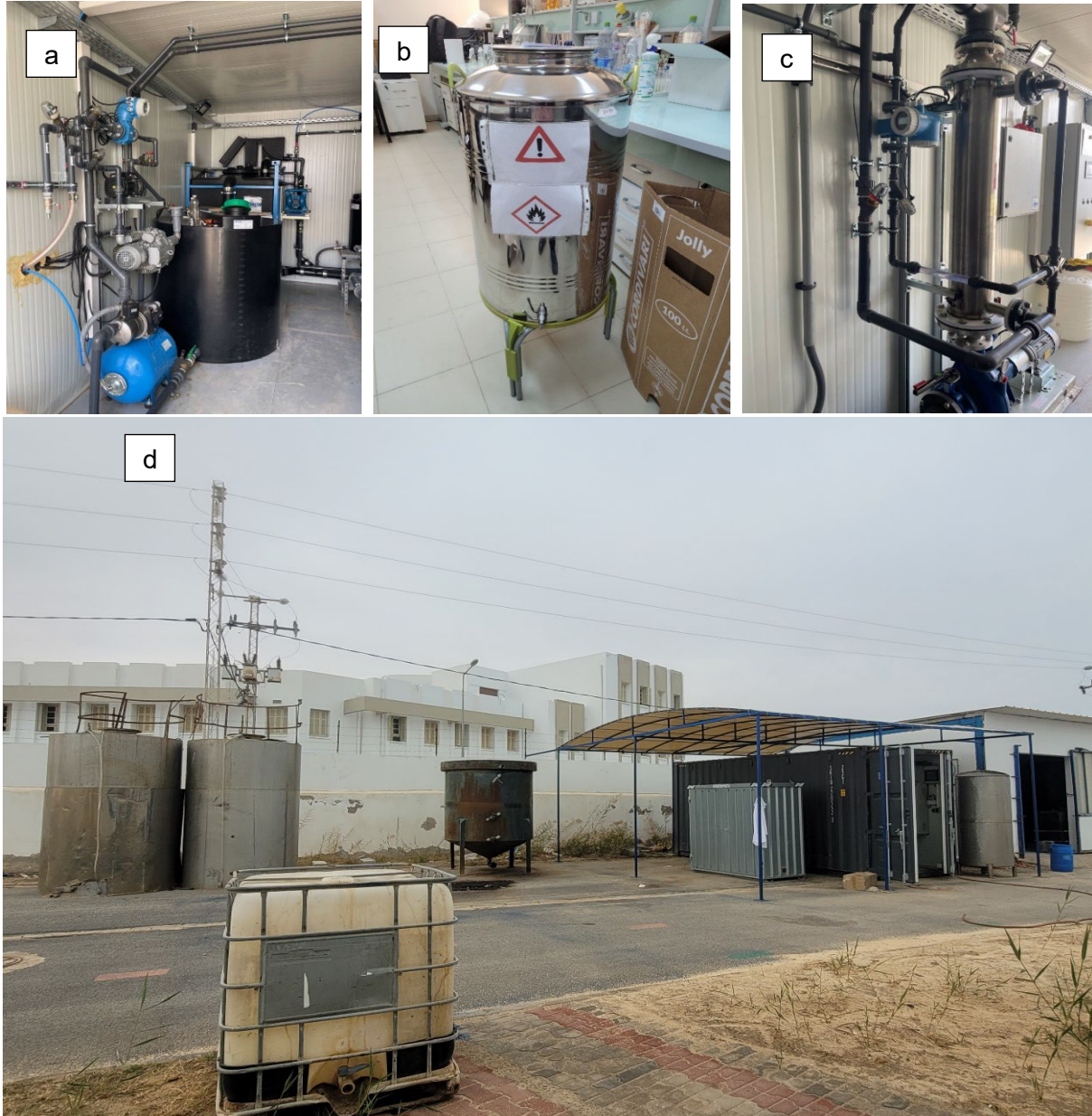
Abbildung 2: (a) Kabel- und Rohrdurchführungen am Container; (b) Gefäß für die Ethanol-Lagerung, (c) kalte Inbetriebnahme der Membrananlage mit Wasser; (d) Gesamtsystem mit 2x6 m³ Vorlagetanks für OMW, Hauptsystem mit allen Anschlüssen (Starkstrom, Druckluft, Deionisiertes Wasser, Leitungswasser, Abwasser), das Ex-geschützte System und Vorlage für die anaerobe Stufe, sowie eine neue Erweiterung: ein Absetzbecken für eine optimierte Vorbehandlung des OMW
