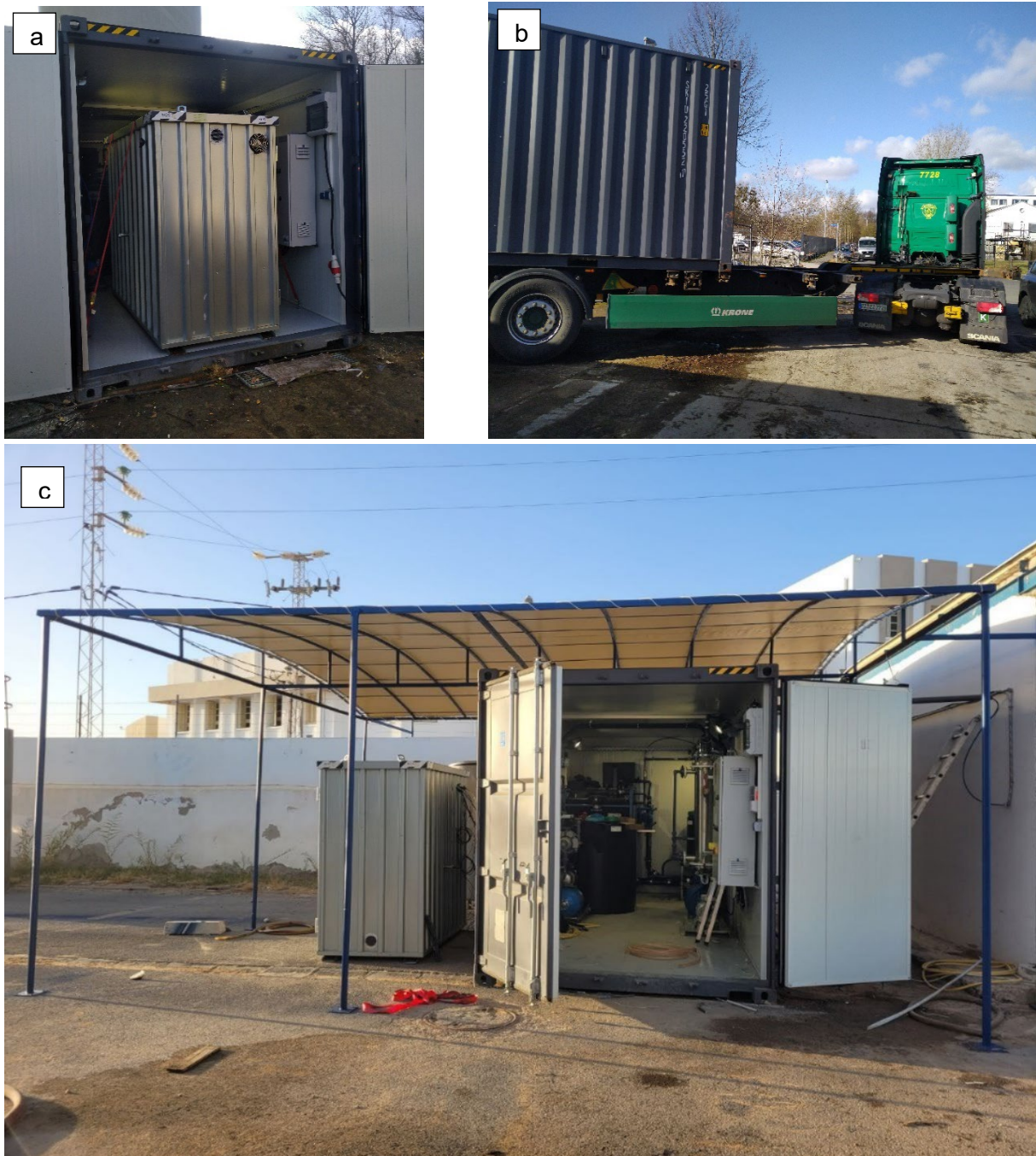
Abbildung 1: (a) Ex-geschützter Container; (b) für den Transport nach Tunesien verladen auf einem Sattelschlepper (c) Installation beider Container mit fest montiertem Sonnen- und Regenschutz am CBS in Sfax, Tunesien
