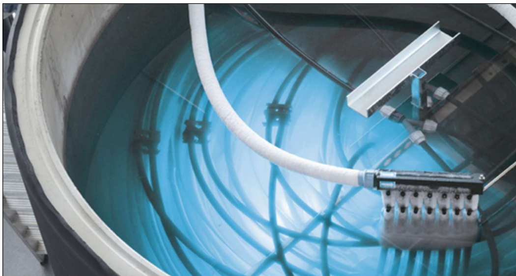
Abb.29: In Wasser eingelassenes Wärmeübertragerrohr des Viessmann VITASET Eis-Energiespeicher [41]
