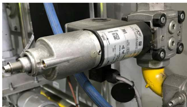
Abbildung 4.5.2-2: Einbausituation Gleichdruckregler und Druckentnahmestelle
