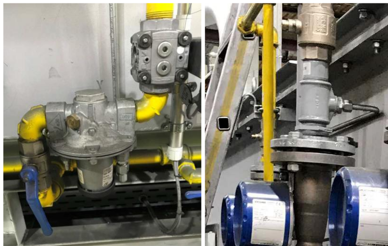
Abbildung 4.5.2-1: Einbausituation Gleichdruckregler und Druckentnahmestelle
