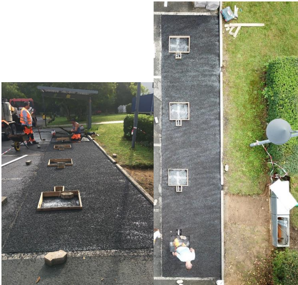
Abbildung 34: Vorbereitete Plätze auf der Asphalttragschicht (Quelle: HsH)
