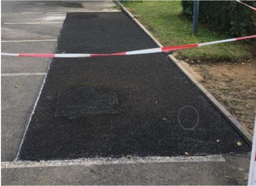
Abbildung 36: Asphaltdeckschicht nach Abschluss der Asphaltarbeiten (Quelle: HsH)
